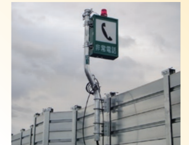
阪神高速道路(株)様 非常電話表示サイン
